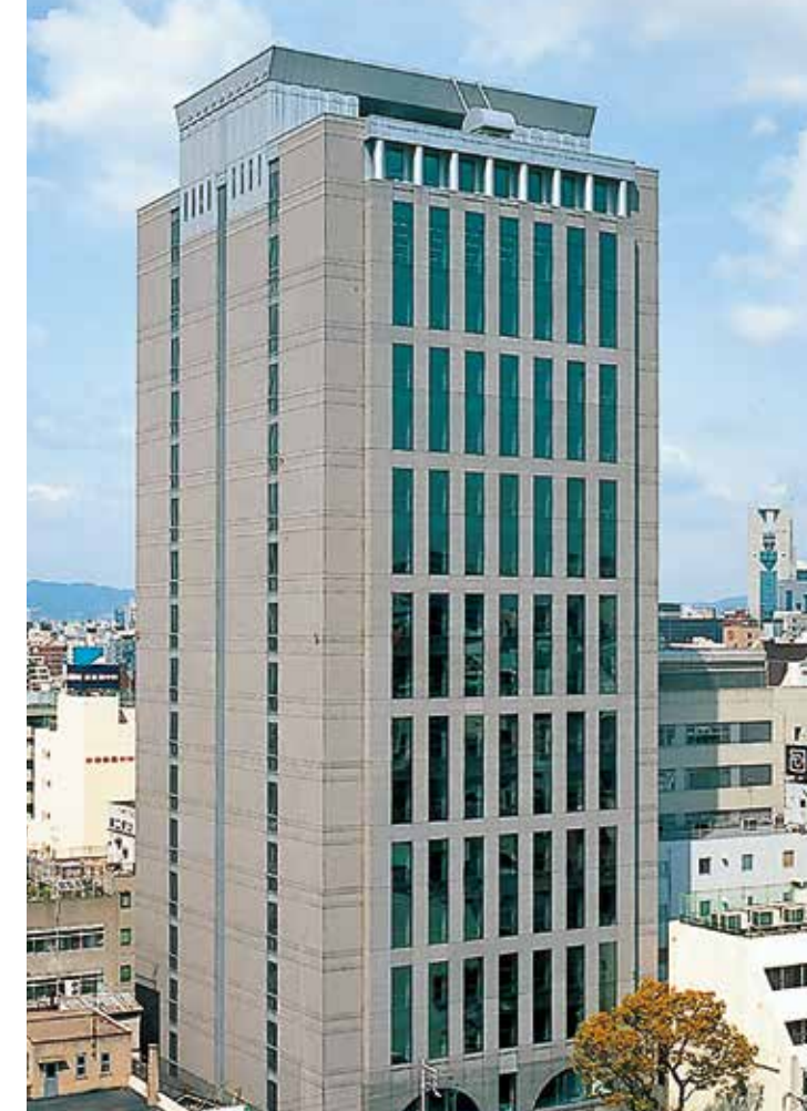
Name : カブコン研究開発ビル Location : 大阪市中央区 Capacity : 57台 Usage : オフィスビル
