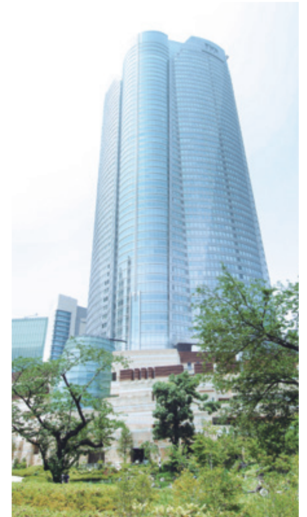
Name : 六本木ヒルズ Location : 東京都港区 Capacity : 668台 Usage : オフィスビル(259台) ホテル(195台) シネコン(214台)
