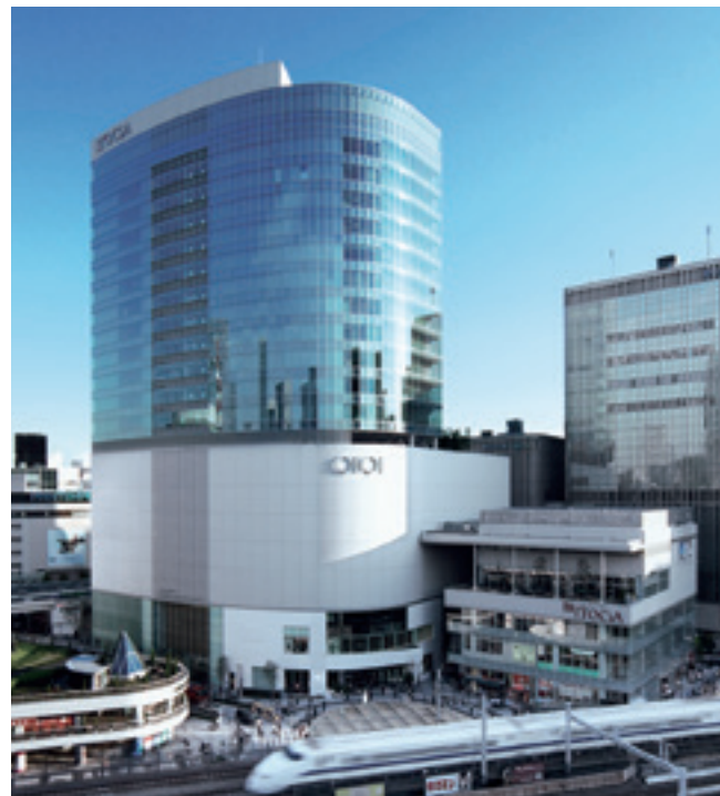
Name : 有楽町イトシア Location : 東京都千代田区 Capacity : 255台 Usage : 複合商業施設
