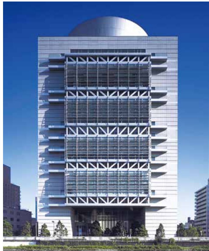
Name : 大阪府立国際会議場(グランキューブ大阪) Location : 大阪市北区 Capacity : 172台 Usage : 会議場
